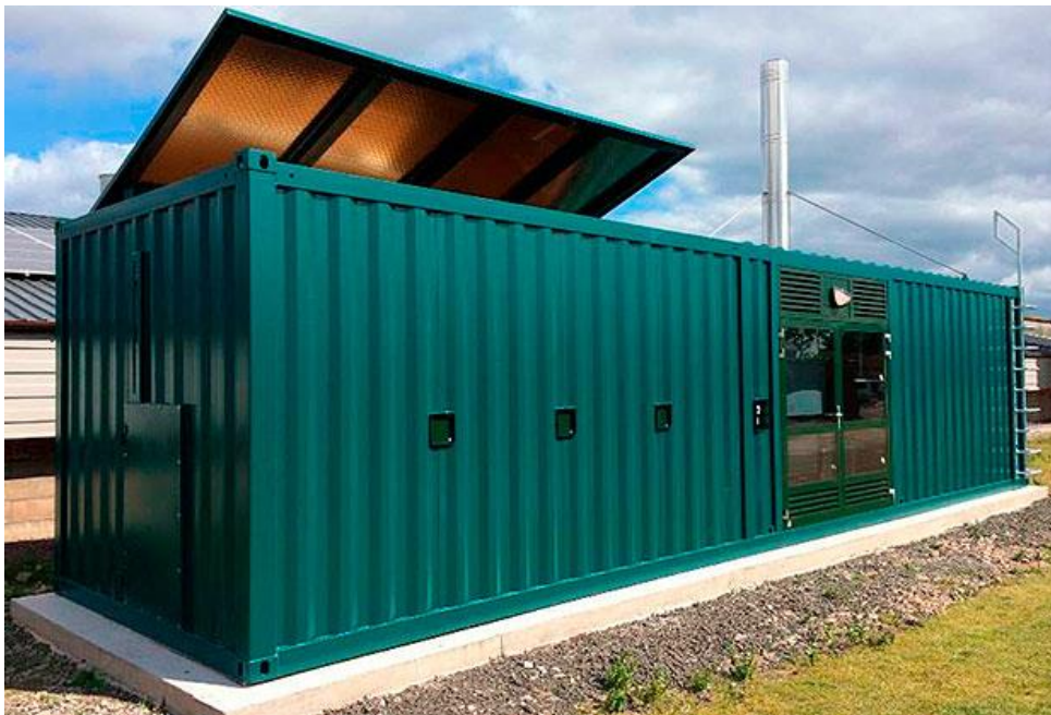
Ilustración 1. Ejemplo de sala de calderas en contenedor de 40' (fuente www.profesionalagro.com )
