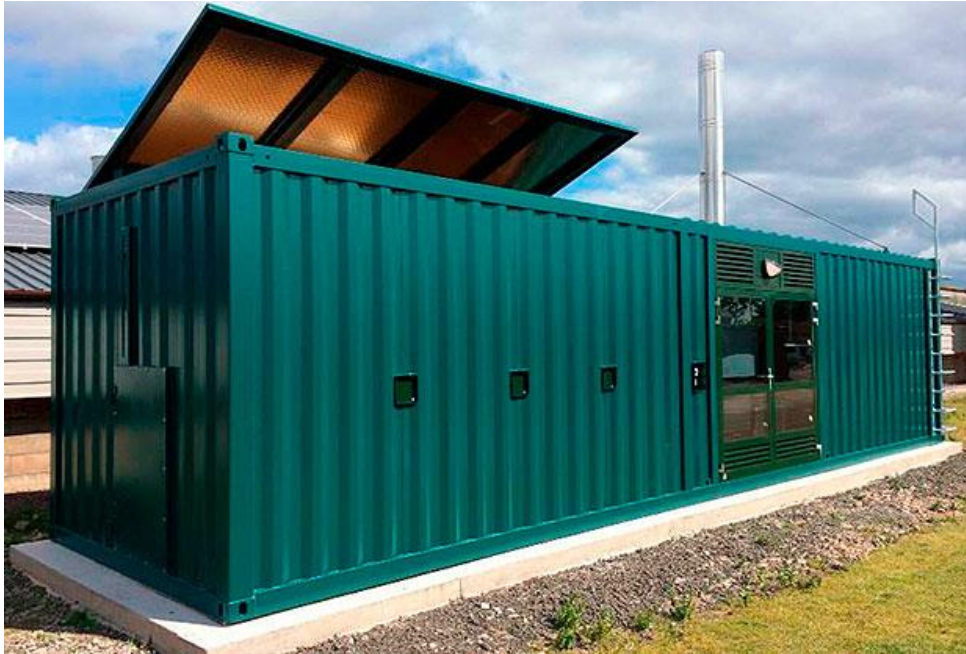
Ilustración 6. Ejemplo de sala de calderas en contenedor de 40' (fuente www.profesionalagro.com )
